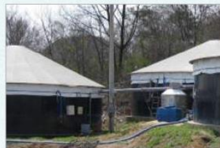
분뇨 탱크 fecal storage tank
